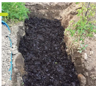
3 腐葉土を入れる
